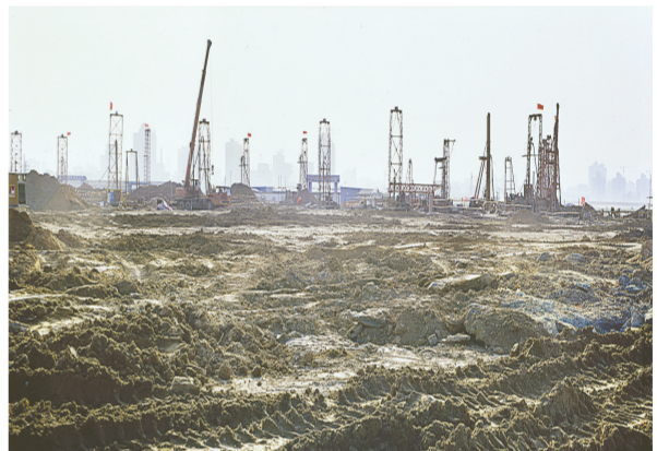
打下基桩的郑州老机场(资料图片)
