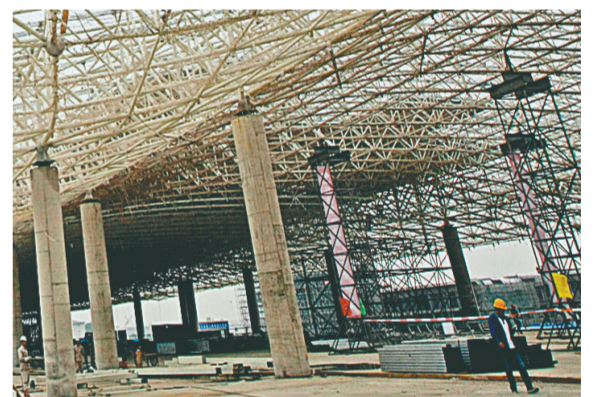
郑州机场二期工程T2航站楼内部装修初具规模
