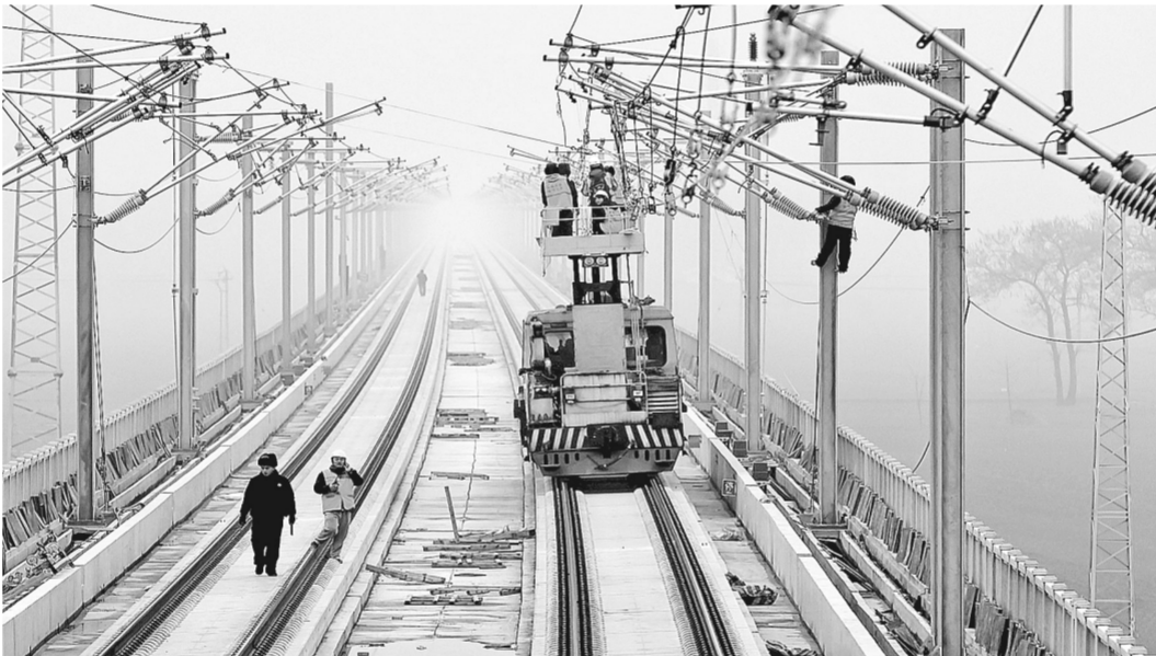
12月7日，中铁电气化局集团三公司的工人在工程车上架设接触网导线。近日，由中铁电气化局集团三公司承建的郑(州)徐(州)客运专线电气化施工进入最后冲刺阶段。据介绍，参建员工在确保施工质量和人员安全的前提下，克服交叉施工、站前滞后、天气恶劣等不利因素，保证了工程有序推进。
