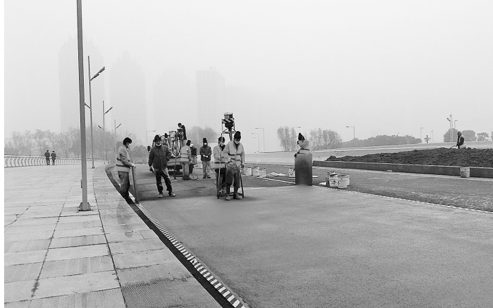
工人正在铺设塑胶自行车道
