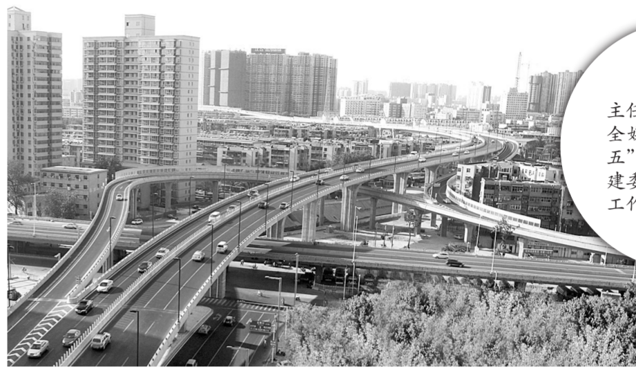
京广快速路工程荣获建筑界最高奖——鲁班奖
