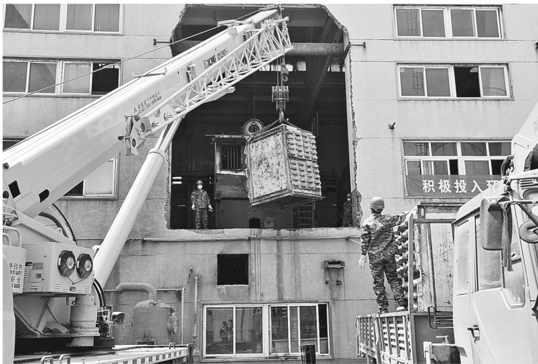
图为施工人员正在拆除燃煤锅炉。全市累计拆改615台燃煤锅炉,每年可减少污染物排放5500吨。
