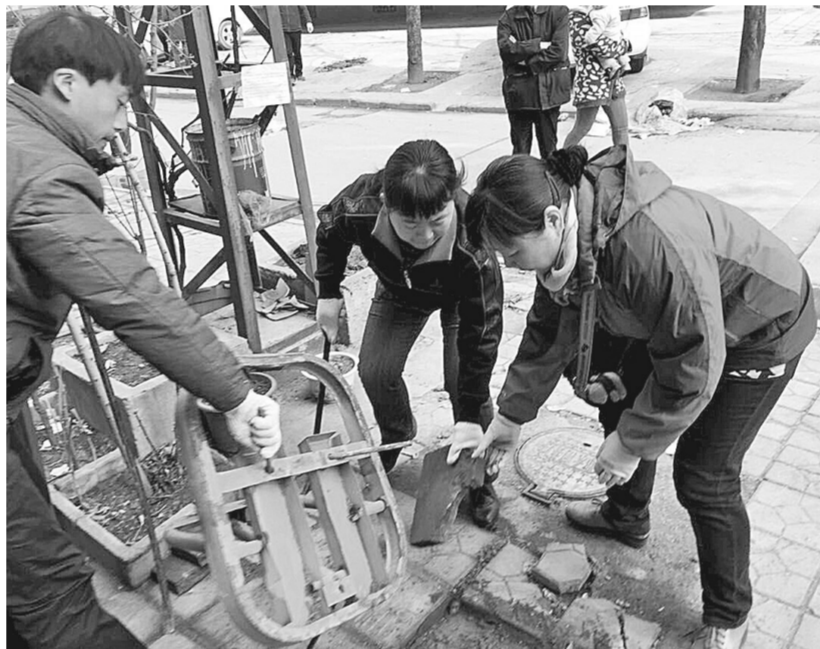
郭琳(右一)和大伙一起维修破损路面。
