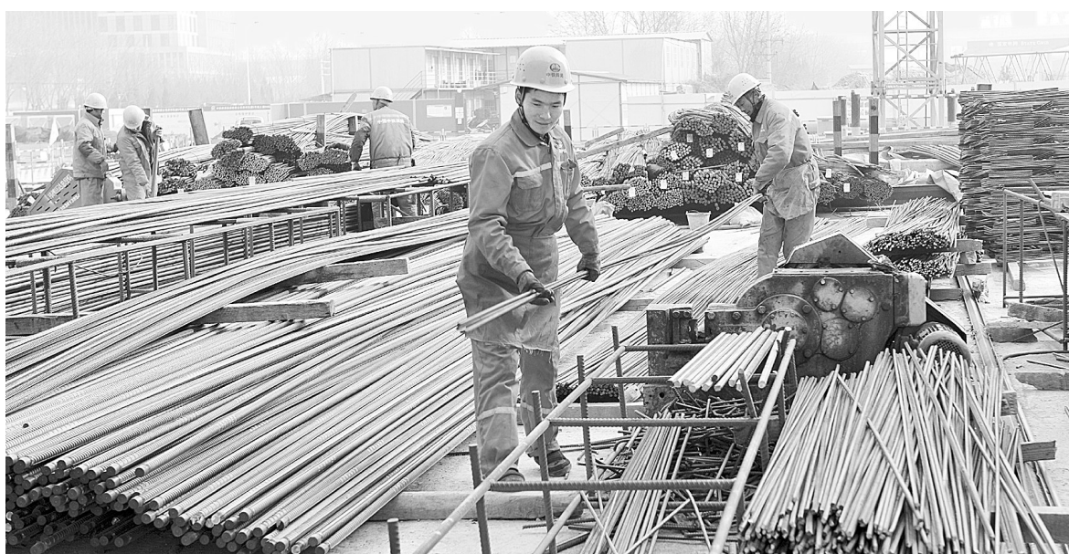
春节期间,承担着我市轨道交通5号线郑东站、中兴路站、康宁路站建设任务的中铁四局城轨公司的1000多名施工人员仍坚守在岗位上,日夜不停地紧张作业。据5号线06标段项目部技术人员介绍,该标段涉及管径较大,施工难度大,是全线体量最大的工程项目。本报记者 丁友明 摄
