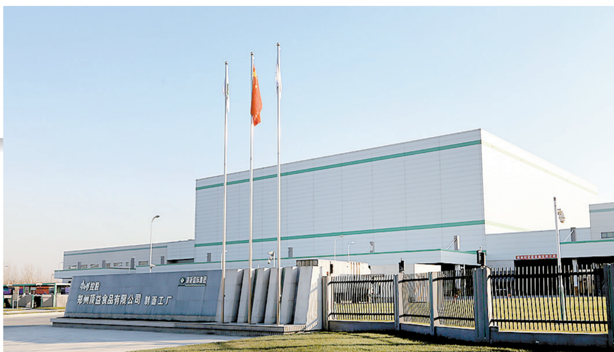
顶新国际集团扩大再投资项目(康师傅新面厂)
