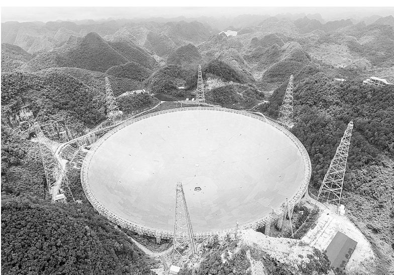
7月3日主体工程完成后的FAST全景
