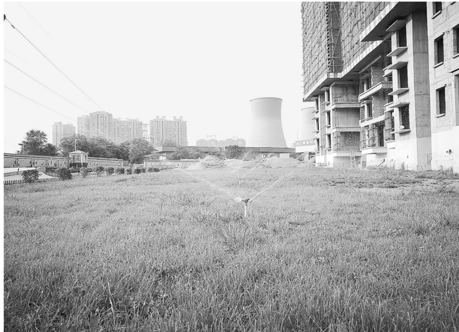
后牛庄安置房项目工地露天地面植绿并安装自动喷淋设施防尘降尘
