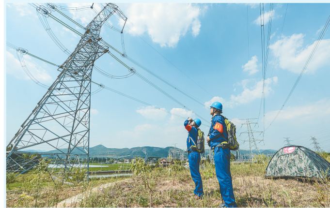
8月29日,浙江省送变电工程公司工作人员在巡视杭州外圈500千伏超高压输电线路。
