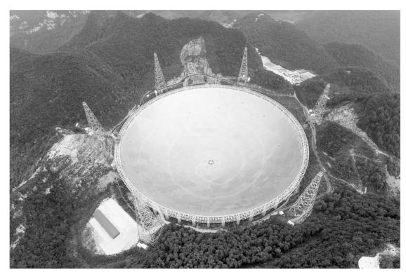
近日,位于贵州省黔南布依族苗族自治州平塘县大窝凼的世界最大单口径射电望远镜一 球面射电望远镜(FAST)工程建设进入收尾阶段,预计9月底整体完工投入使用。FAST拥有30个足球场大 的接收面积,与号称"地面最大的机器"的德国波恩100米望远镜相比,灵敏度提高约10倍。它将在未来10 至20年保持世界一流设备的地位。
