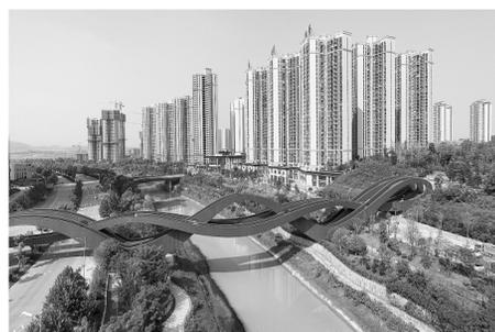
长沙梅溪湖“中国结”步行桥近日全面建成,全长183.95米,由直线形“散步道”和拱形“登山道”多段桥身交叉组成。
