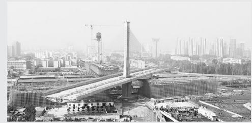
8日，在两台350吨连续式千斤顶的牵引下，自重达2.48万吨的山东菏泽丹阳路立交桥东侧主桥逆时针转动81.67度，与引桥实现精准对接，当今世界转体重量最大的斜拉桥成功“转身”。丹阳路立交桥跨越京九、新兖铁路及菏泽货场，施工部门采取“先建后转”工艺，先沿铁路平行方向建设桥体，再建好桥体沿逆时针方向转体至设计位置。
