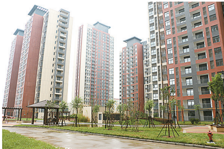
马寨程炉张河安置区一期实景图
