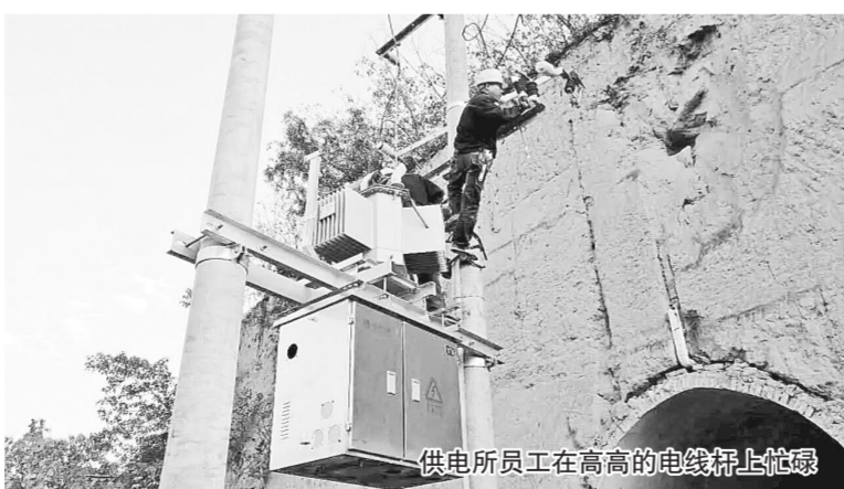
供电所员工在高高的电线杆上忙碌
