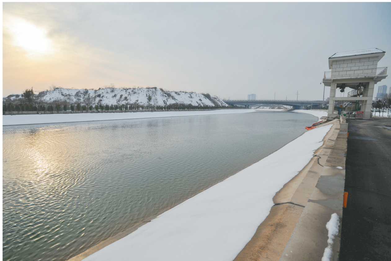
记者从南水北调中线建设管理局获悉,截至25日,南水北调中线一期工程已累计调引“南水”超过60亿立方米。其中,郑州累计受水5亿多立方米。图为南水北调中线郑州段干渠。 新华社发
