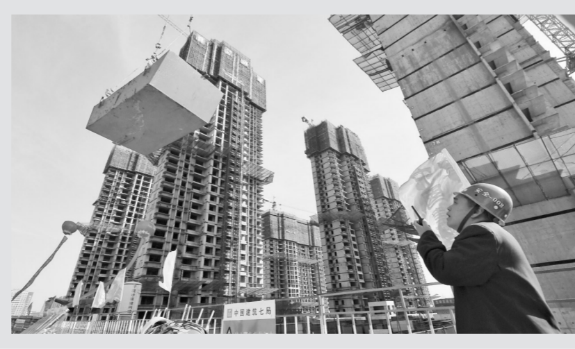
春节临近,又一条好消息传来——随着高新区朱砦安置房项目4号、7号楼主体结构最后一罐混凝土圆满浇筑完成,标志着朱砦安置房项目主体顺利封顶。该项目于去年4月开工,计划明年1月竣工,建成后,预计可安置1420户,4541人。 本报记者 李焱 摄
