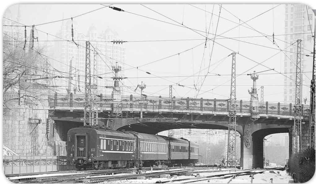
2月12日，为了配合哈尔滨火车站铁路电气化改造工程，哈尔滨启动霁虹桥新建跨铁路连接桥工程，对霁虹桥的连接桥开始半封闭施工。霁虹桥是一座典型的欧式桥梁建筑，是全国重点文物保护单位中东铁路建筑群的组成部分。新华社记者王凯摄
