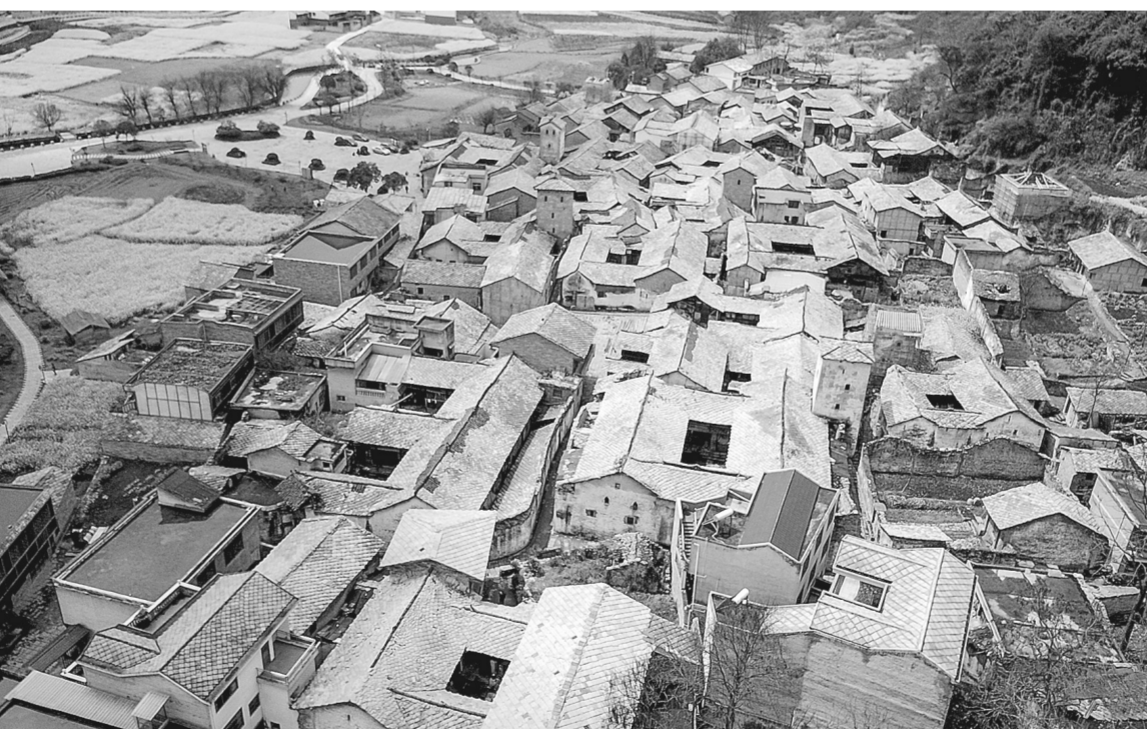
这是3月22日拍摄的贵州省安顺市本寨古村。本寨古村是安顺地区现存较为完整的明清古村落之一。这里的建筑用石砌奠基,石块砌墙,石板盖顶,风格独特、古韵悠悠,是全国重点文物保护单位、中国历史文化名村。 新华社发
