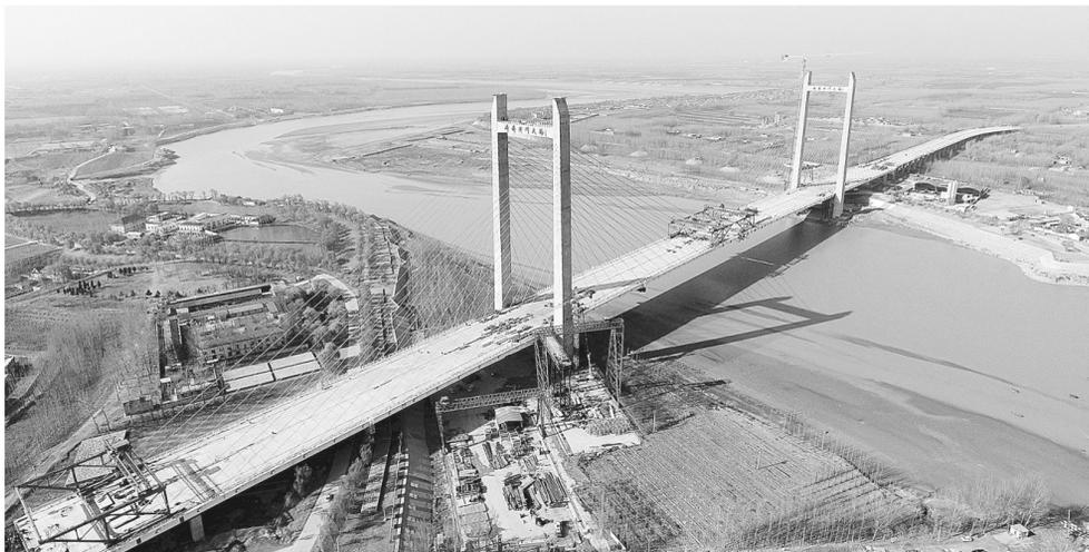
3月26日,正在进行合龙施工的济青黄河公路大桥。当日,横跨黄河山东段,连接山东省济南、德州两市的济青黄河公路大桥顺利完成合龙。该桥全长2287米,宽度35.5米,采用双向六车道一级公路技术标准,预计今年7月份开放通车。
