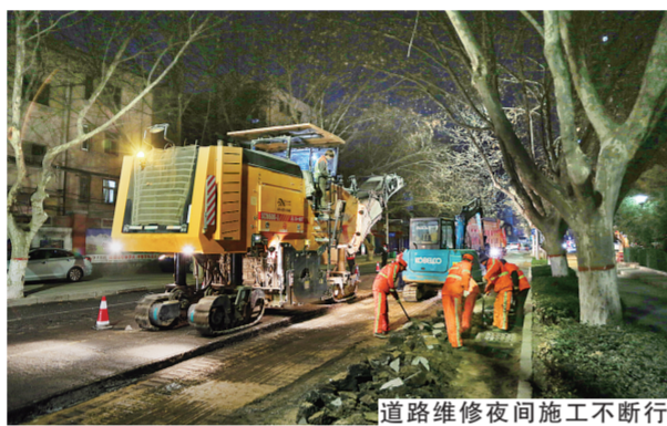
道路维修夜间施工不断进行
