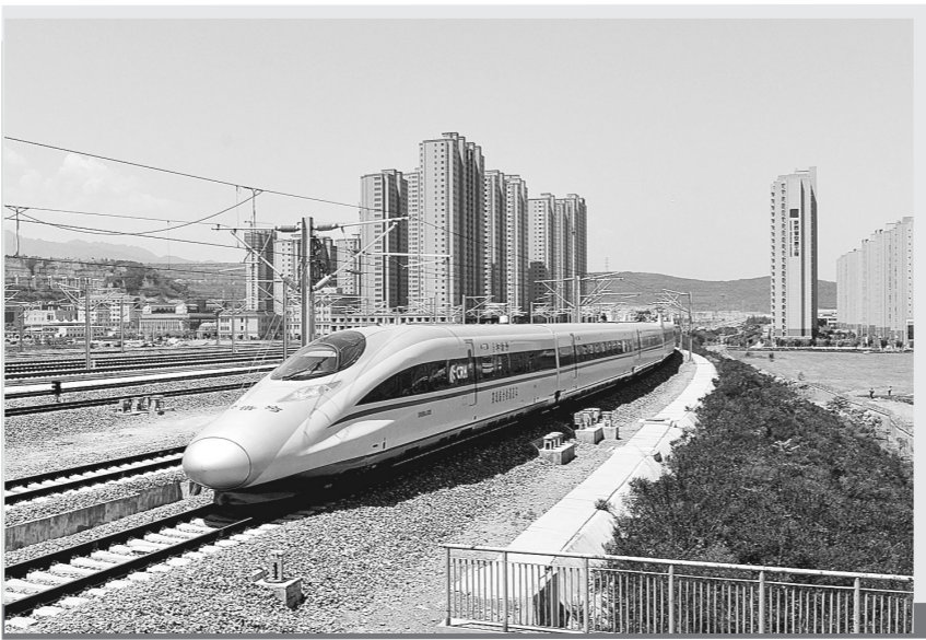
据西安铁路局消息,宝鸡至兰州高速铁路将于7月9日开通运营,铁路部门将于7月6日16时开始发售宝兰高铁相关列车车票,它的开通标志着西北地区全面融入全国高速铁路网。图为在陕西宝鸡,一列高速综合检测列车在宝兰高铁上行驶(5月16日摄)。
