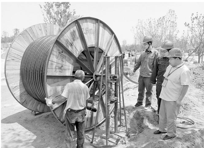
本报讯(记者 葛春洁 文 宋晖 图)记者昨日从郑州供电公司了解到,目前园博园供电配套工程已全部竣工。自去年3月园博园开工建设以来,郑州供电公司作为园博园共迁改6条10千伏线路,新建4座开闭所,新建电缆24公里,新建架空线路15公里。目前所有工程已经竣工,并且实现了正常送电。图为供电公司工作人员在进行扫尾工作。
