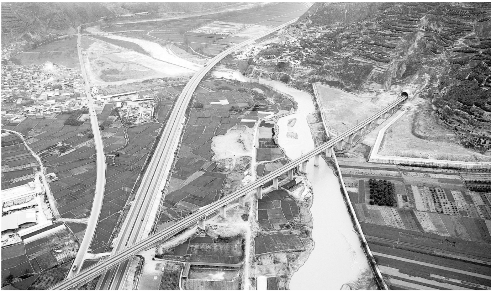
兰渝铁路甘肃陇南境内的汉王特大桥(右)与高速公路及国道交错(2016年12月25日摄)。 2016年12月26日,兰渝铁路(岷广段)通车;2017年6月19日,兰渝铁路施工难度极大的胡麻岭隧道贯通,为铁路全线通车扫除了最后障碍。兰渝铁路从百年前孙中山先生《建国方略》规划中走来,终于在中华民族反贫困最后决战中贯通,给沿线数百万贫困人口送上最珍贵的礼物。这一高投入、高难度的“扶贫路”得以修成,体现了中国社会主义集中力量办大事的制度优势和政治优势。 新华社记者 陈斌 摄
