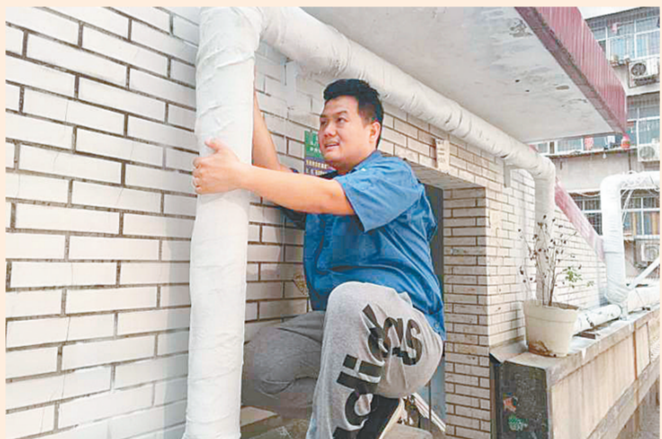
施工人员对管网进行改造升级
