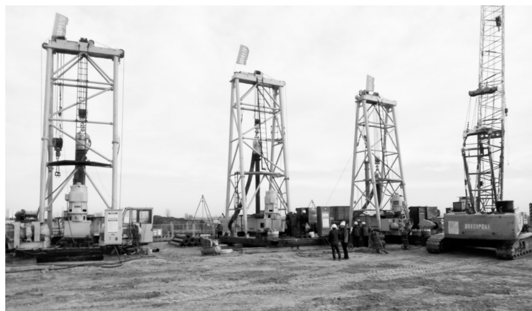
随着3台回旋钻机开始运转,郑济铁路郑州黄河特大桥主体382号墩2号、4号、6号桩基同时开钻,标志着该大桥主体工程开建。郑济高铁是我省“米”字形高速铁路网最后落笔的“一点”,郑济铁路黄河特大桥是郑州至济南快速铁路的控制性节点工程。本报记者 丁友明 摄
