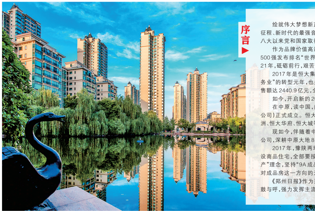
▲洛阳恒大绿洲项目实景图
