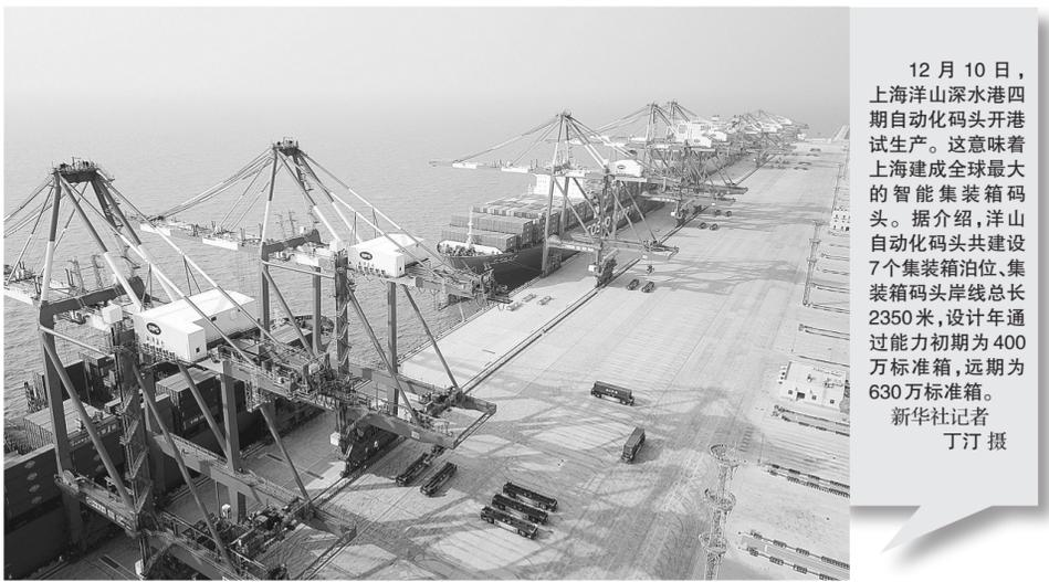
12月10日，上海洋山深水港四期自动化码头开港试生产。这意味着上海建成全球最大的智能集装箱码头。据介绍，洋山自动化码头共建设7个集装箱泊位，集装箱码头岸线总长2350米，设计年通过能力初期为400万标准箱，远期为630万标准箱。新华社记者 丁汀 摄
