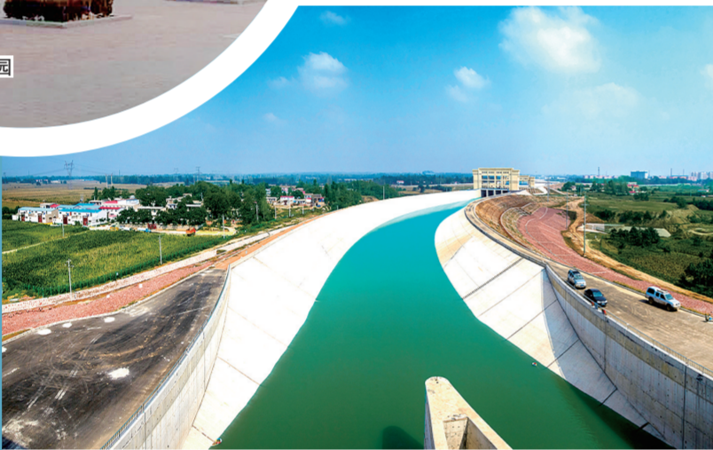
▲ 南水北调中线工程总干渠
