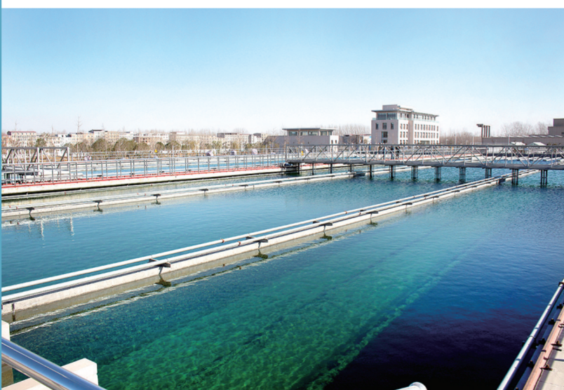
▲ 郑州航空港区第二水厂沉淀池
