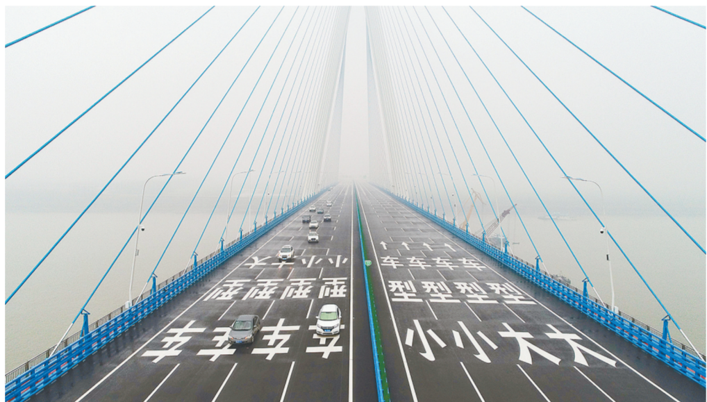
12月28日,长江上最宽桥梁——武汉沌口长江大桥实现通车运营。跨江大桥桥型为五跨一联双塔双索面钢箱梁斜拉桥,全长1510米,主跨760米,桥面宽46米,为目前长江上已建成的最宽桥梁。 新华社记者 熊琦 摄
