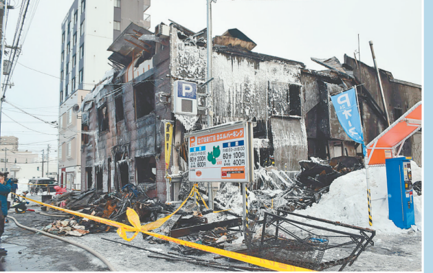
这是2月1日在日本北海道札幌市拍摄的火灾现场。日本北海道札幌市一处公益建筑物1月31日夜发生火灾,造成11人死亡、3人受伤。新华社发
