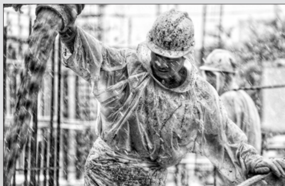
建筑工人冒着风雪在工地进行混凝土浇筑施工。
