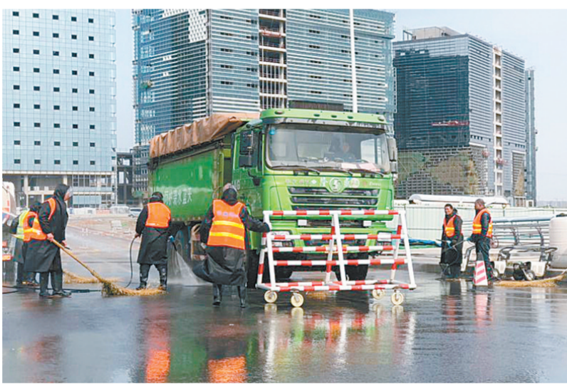
工程车经过水枪冲洗从工地内驶出
