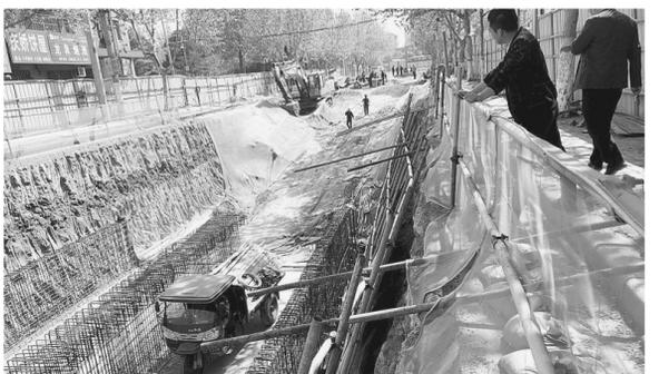
本报讯(记者 史治国 通讯员 邵家见 文/图)昨日,记者在荥阳惠厂小学门口看到,荥阳市生态雨水涵道正在紧张施工中。住建局生态办工作人员高振江说:“雨水涵道建成后,涵道内能够跑家庭轿车,将使荥阳城区雨天不再积水。”
