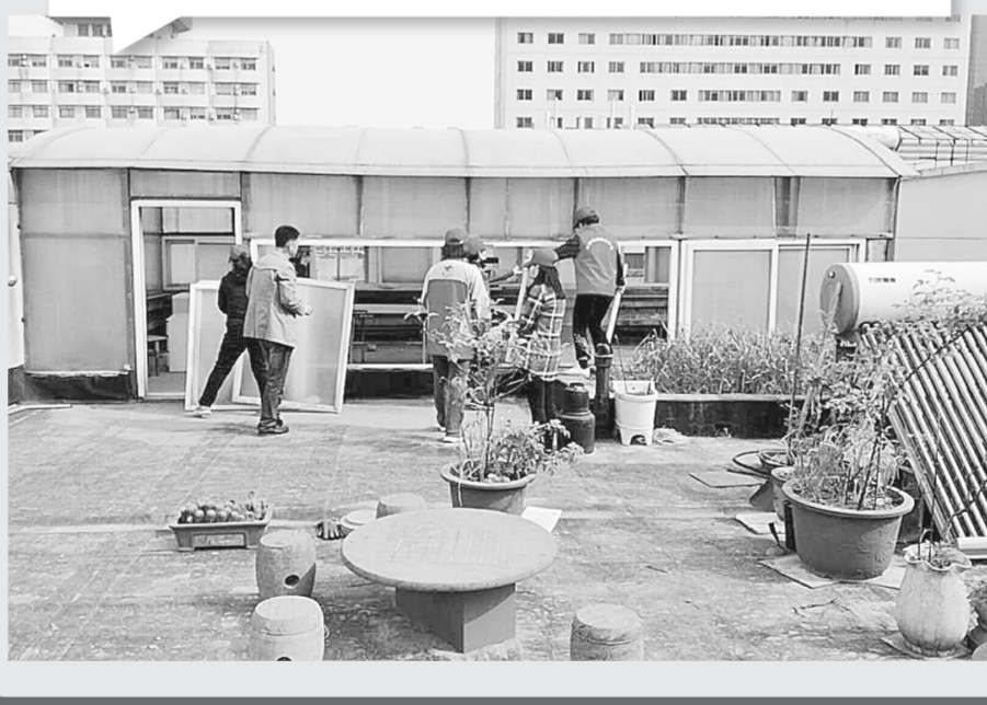
公共屋顶被近水楼台者建了私家“阳光房”，群众怨言很大。4月10日上午中原区林山寨街道办事处将陇海西路352号院5号楼顶层60平方米的阳光房进行了整体拆除。 本报记者 孙志刚 摄
