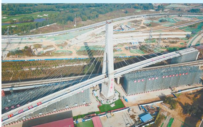
自带弧度和大陡坡、形似一轮新月和登云天梯的1.65万吨斜拉桥24日凌晨在郑州近郊的夜幕中转体成功,标志着在建的郑万铁路顺利跨越徐兰高铁,同时也填补了国内小曲线、大纵坡、大偏心转体斜拉桥施工的空白。
