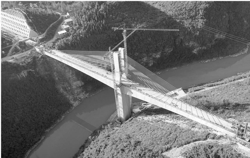
10月29日,由中铁十一局五公司承建的黔(重庆黔江区)张(湖南张家界市)常(湖南常德市)铁路长湾澧水大桥成功合龙。长湾澧水大桥全长369.1米,是黔张常铁路全线重难点控制性工程之一。 新华社发
