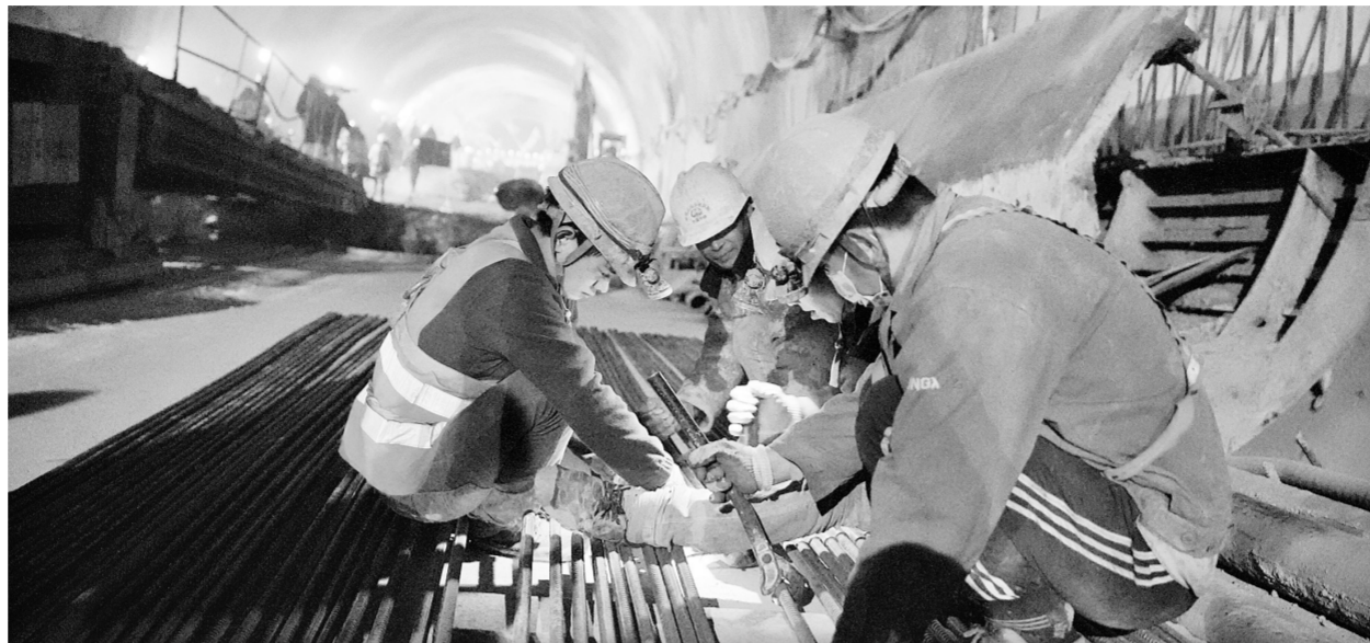
12月13日,工人在隧道内施工。当日,京张高铁新八达岭隧道贯通,标志着京张高铁建设取得突破性进展。新华社记者 邢广利 摄
