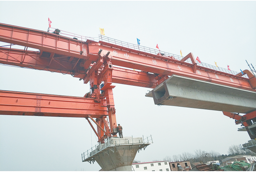
昨日,郑州南站至郑州动车所铁路走行线首片箱梁成功架起
