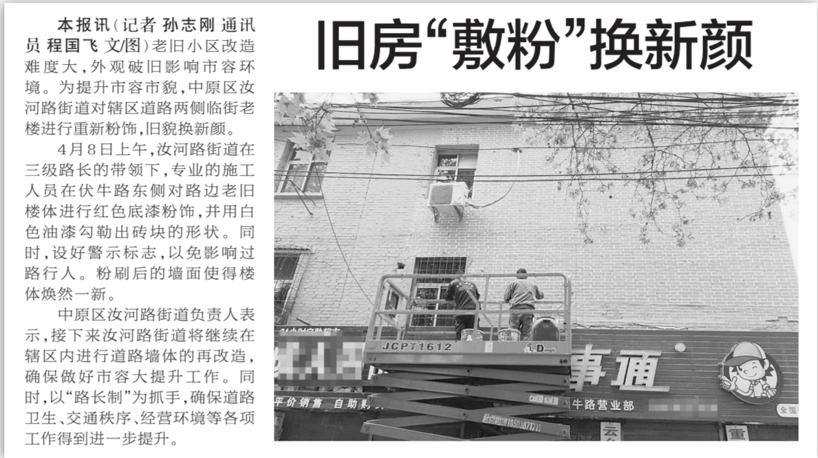
本报讯(记者 孙志刚 通讯员 程国飞 文图)老旧小区改造难度大,外观破旧影响市容环境。为提升市容市貌,中原区汝河路街道对辖区道路两侧临街老楼进行重新粉刷,旧貌换新颜。
