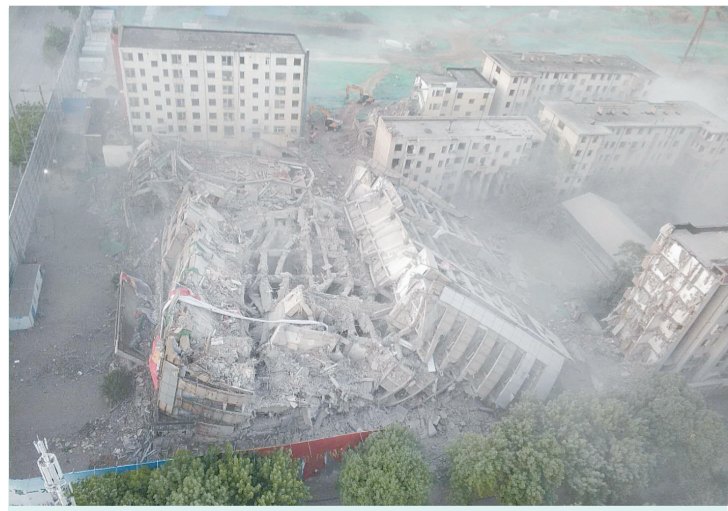
昨日凌晨5时36分,随着爆破现场指挥长一声令下,昔日郑州地标建筑——位于经三路和红专路交会处西南角的冰熊大厦应声而倒。随后,几辆待命的降尘雾炮车在确认安全后,第一时间驶入现场,喷出数米高的雾粒,进行降尘处理。
