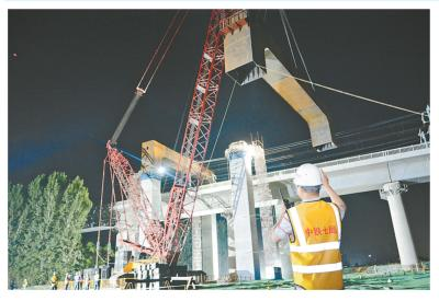
本报讯(记者 聂春洁 通讯员 姬 昆生 赵亚龙 文/图)6月3日,经过4次封锁要点施工,由中铁七局承建的郑济高铁上跨徐兰高速铁路两处钢横梁架设顺利完成,在跨高铁吊装重量、吊装高度方面均刷新了国内新纪录。
