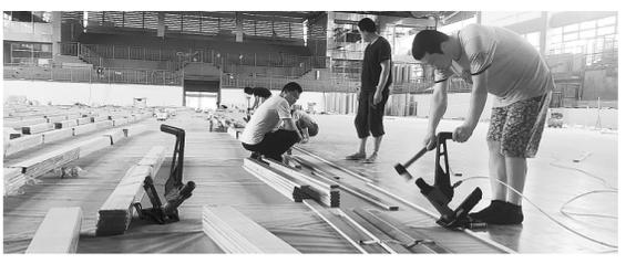
场看到,工人们有的在铺设新的木质地板,有的在安装吸音板,有的在粉刷墙面……“内部的装修和整改主要涉及地面的更换,整个场馆观众座椅的更换,以及墙壁内室和顶部网架结构的重新喷涂。”杨征对记者说,“灯光、消防监控、空调、网络、旗帜升降等系统进行了全新升级或加装。另外,在场馆内看台下的房间已进行全面改造,用于嘉宾休息区、媒体工作室、新闻发布间、裁判员运动员休息室等。升级改造后的场馆在外观、功能以及布局上会更加美观,更加完善,更加合理,相信一定能够满足民族运动会射箭比赛的需求。”
