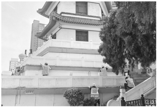
二七广场建筑正在进行光源布置
