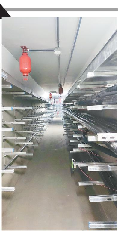
管廊中氧气含量或者温湿度出现异常,监测系统会第一时间发出警报,同时自动启动风机,让整个管廊自在“呼吸”。”监控中心负责人介绍。
