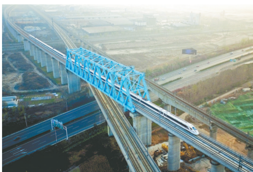
列车经过西成高铁跨西宝高铁特大桥
