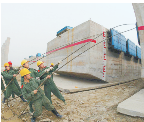
三峡永久船闸处的水泥浮船做最后的定位
