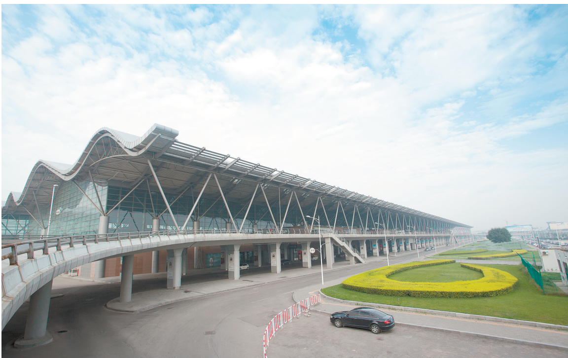
新郑国际机场一期航站楼
