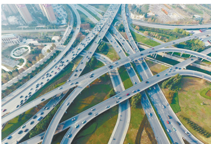
错综复杂的立交桥
