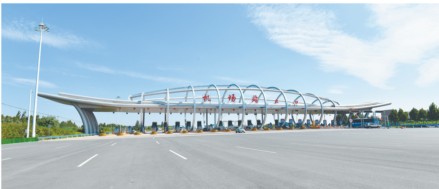
新建机场高速公路收费站
