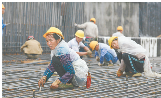
风雨中,建筑工人坚守岗位
