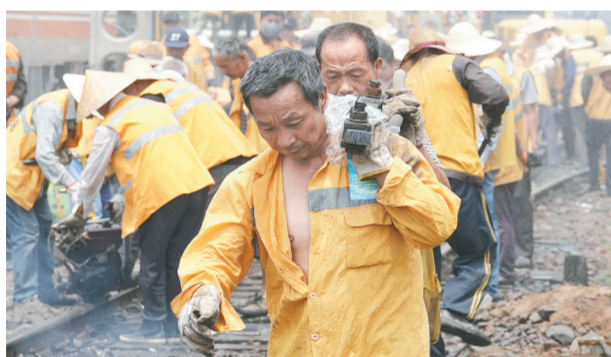
烈日下,铁路工人进行更换道岔施工
